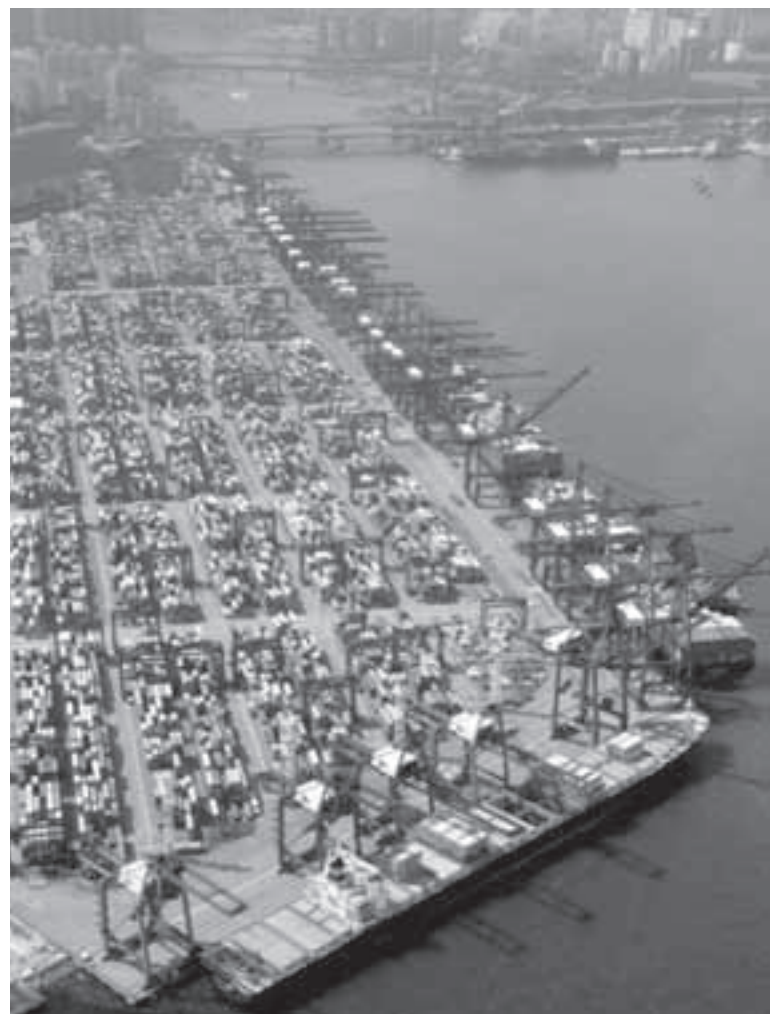
پایانه مدرن ترمینالز در بندر هنگ‌کنگ با آرایش صفای ترانستینر و جانمایی خطوط کانتینری موازی با راستای امتداد اسکله.
