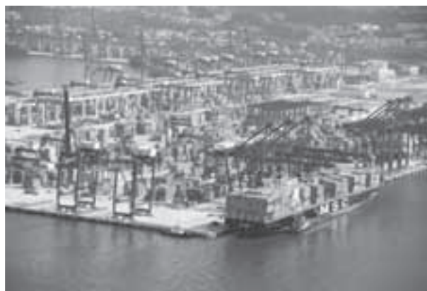
پایانه پازیر پان یانگ در سنگاپور با آرایش تجهیزات صفافی OHBC و جانمایی خطوط کانتینری موازی با راستای امتداد اسکله.
