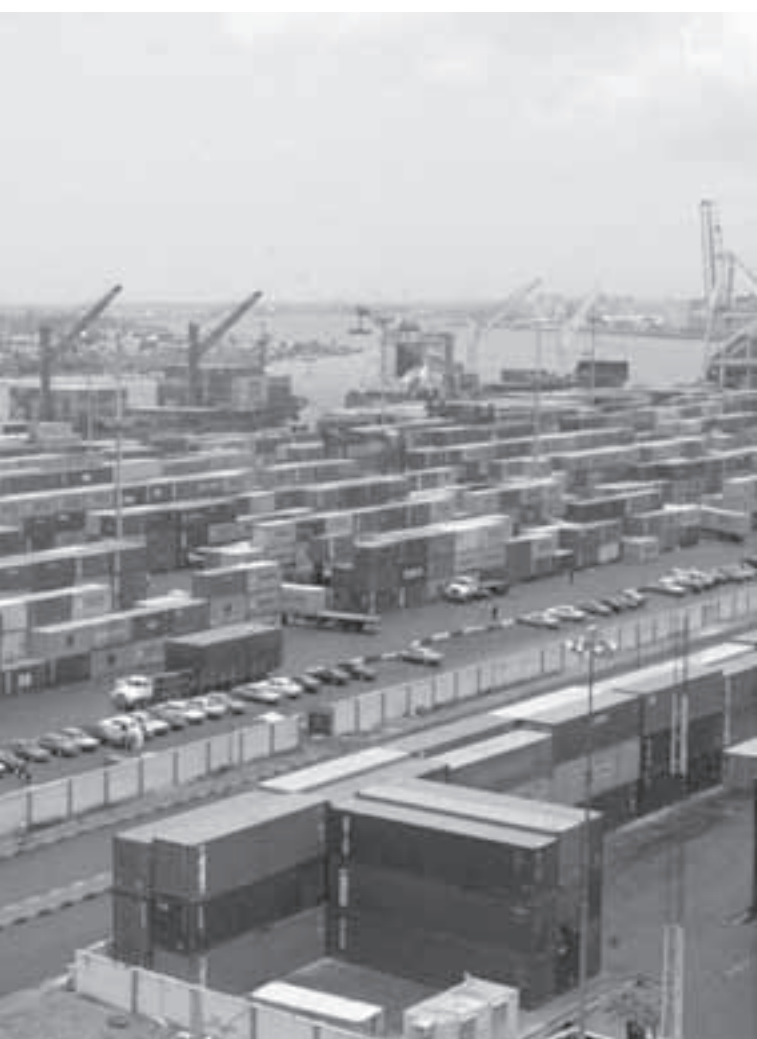
پایانه کانتینری ای.سی.تی. دلتا در بندر روتردام که از ترانستینر ریلی خودکار به عنوان تجهیزات صفافی محوطه استفاده می کند. جانمایی خطوط کانتینری به صورت آرایش قائم با امتداد اسکله است.
