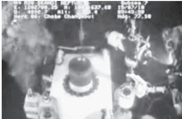
ROVها در حال نصب در پوشش بر روی سیستم فوران گیر چاه هستند (ژوئیه ۲۰۱۰)
